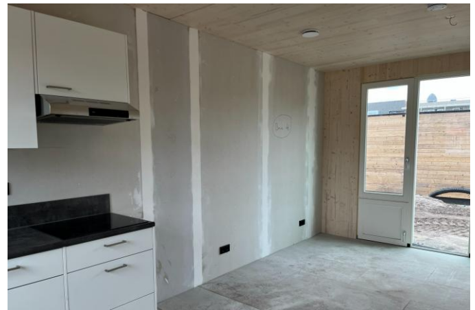
VOORBEELD WANDEN MET GIPSAFWERKING
