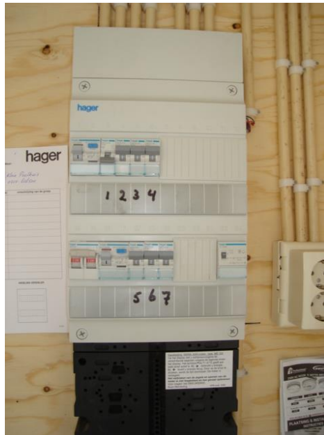
Groepenkast: in totaal 7 groepen verdeeld over 2 aardlekschakelaars.
