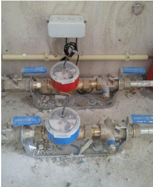
De meterkast met de watermeters voor Warm tapwater (rood) en koud water (blauw)
