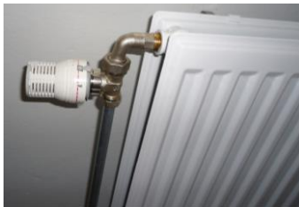
Thermostaatkraan: reageert niet via de kamerthermostaat
