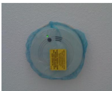
Afbeelding van rookmelder, nog voorzien van een afdekhoesje.
