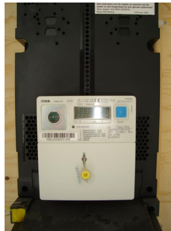
Fig.: 3.6.4 Digitale weergave elektriciteitsverbruik
