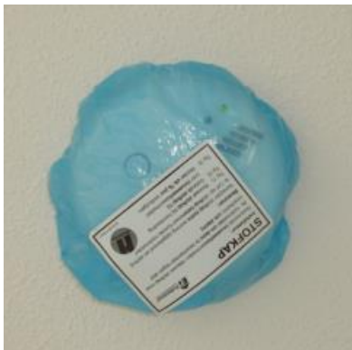
Fig.: 4.1.1 De rookmelder is voorzien van een blauw hoesje.
