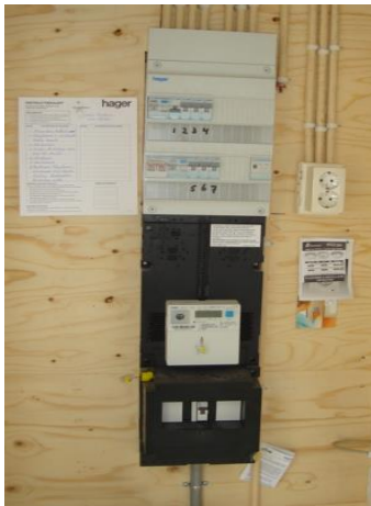
Fig.: 3.6.1 De meterkast
